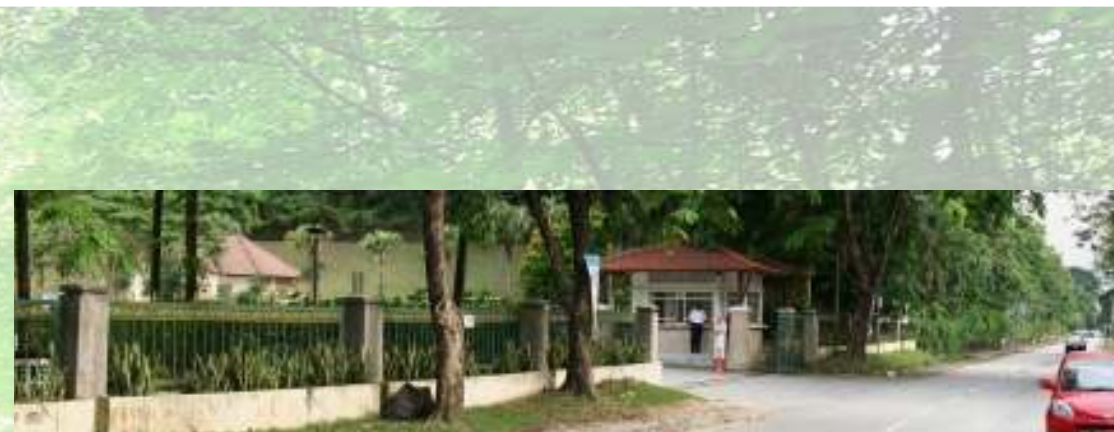
PINTU MASUK UTAMA
